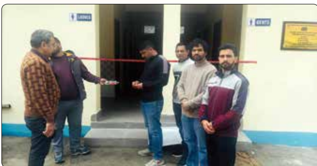
सुंडला बाजार में सार्वजनिक शौचालय का निर्माण
