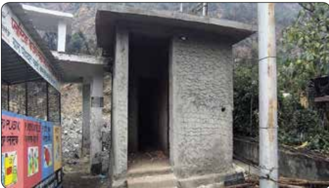
लारजी में सार्वजनिक शौचालय का निर्माण
