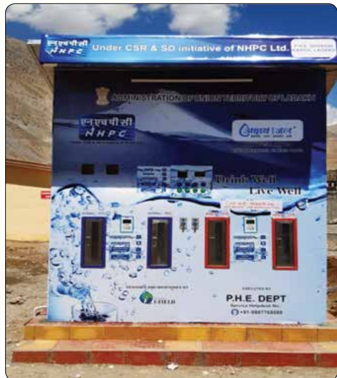
नए जिला अस्पताल, कुर्बाथांग, कारगिल में 250 एलपीएच क्षमता के वाटर एटीएम की स्थापना
