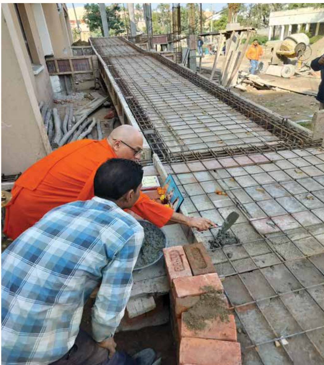
रामकृष्ण मिशन मेडिकल सेंटर, जम्मू में नेत्र देखभाल इकाई की स्थापना, नेत्र शल्य चिकित्सा कक्ष की मरम्मत और पुनर्निर्माण, कैनोपी सहित रैंप का निर्माण
