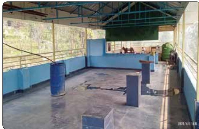
माखा सीनियर सेकेंडरी स्कूल में स्टील ट्रस फैब्रिकेशन का निर्माण
