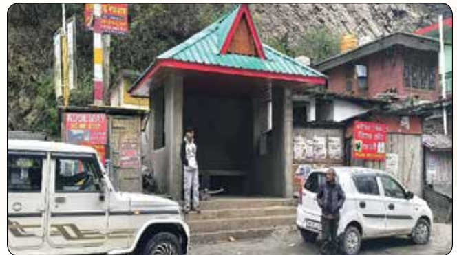
ग्राम पंचायत लारजी में वर्षा आश्रय का निर्माण
