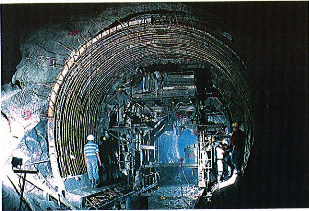
280 मेगावाट की धौलीगंगा परियोजना (उत्तरांचल) - इनटेक टनल की कंक्रीट लाइनिंग
