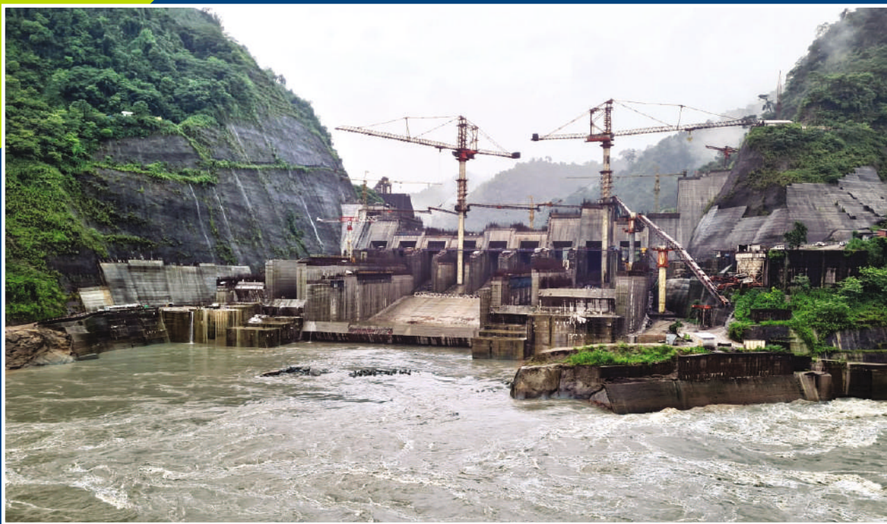
2000 मेगावाट सुबानसिरी लोअर परियोजना (अरुणाचल प्रदेश/असम) – निर्माणाधीन बांध
