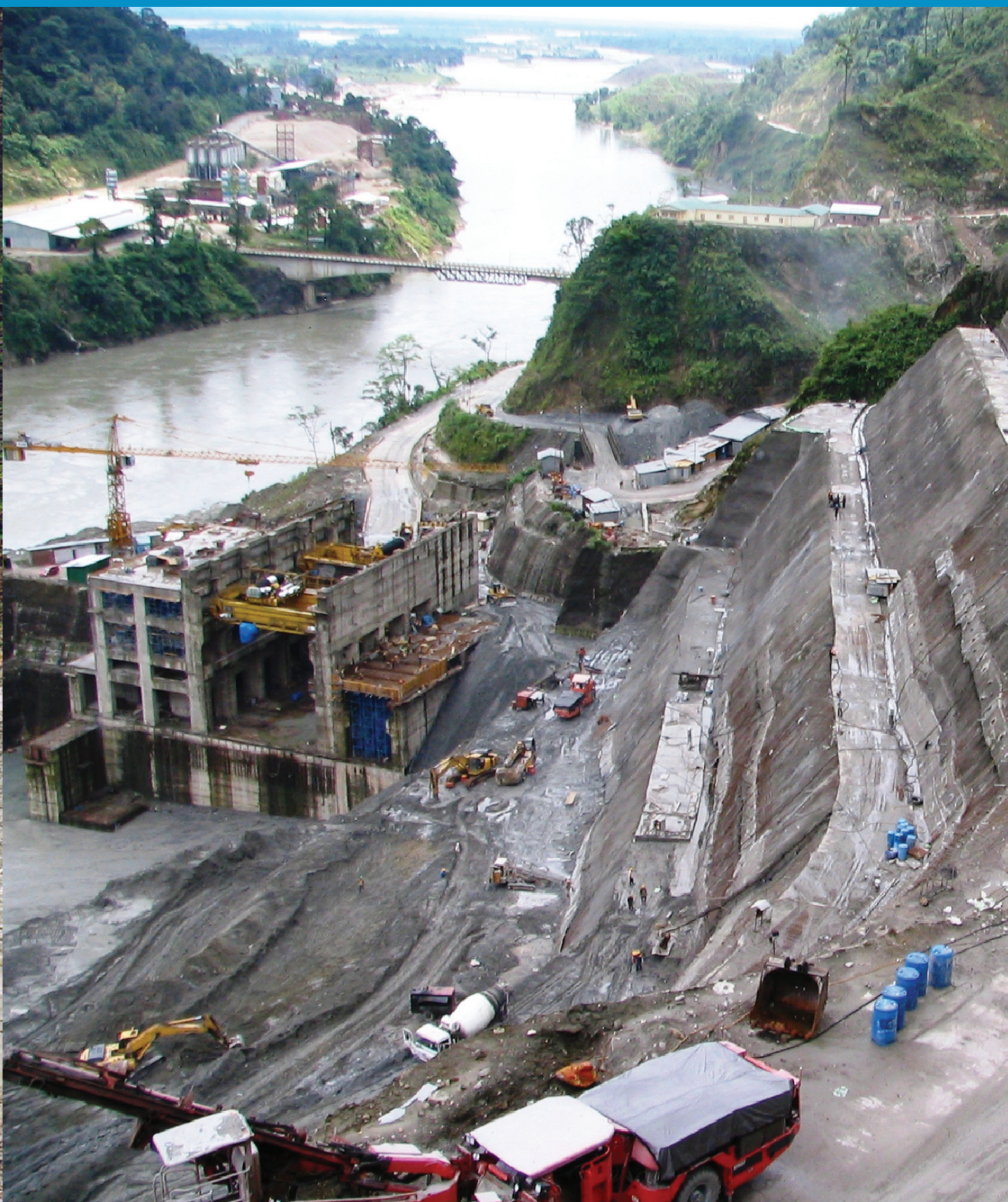
2000 मेगावाट सुबानसिरी लोअर परियोजना (अरुणाचल प्रदेश/असम) - निर्माणाधीन पावर हाऊस
