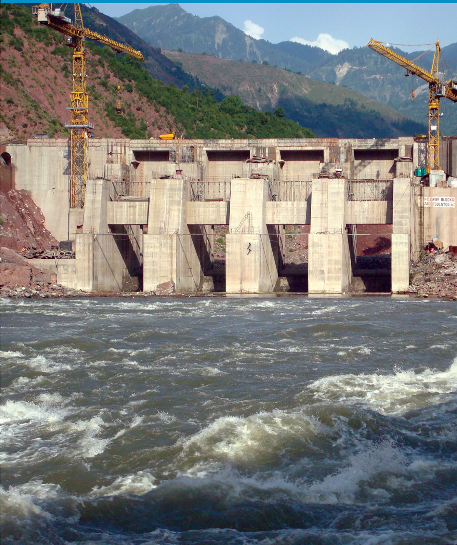
240 मेगावाट उड़ी-II परियोजना (जम्मू एवं कश्मीर) - निर्माणाधीन कंक्रीट बांध
