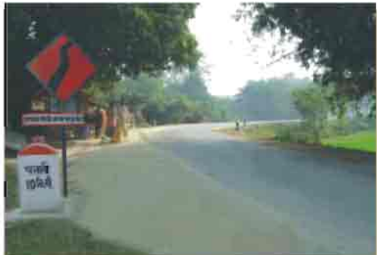
पीएमजीएसवाई के अंतर्गत बिहार में एनएचपीसी द्वारा सड़क का निर्माण
