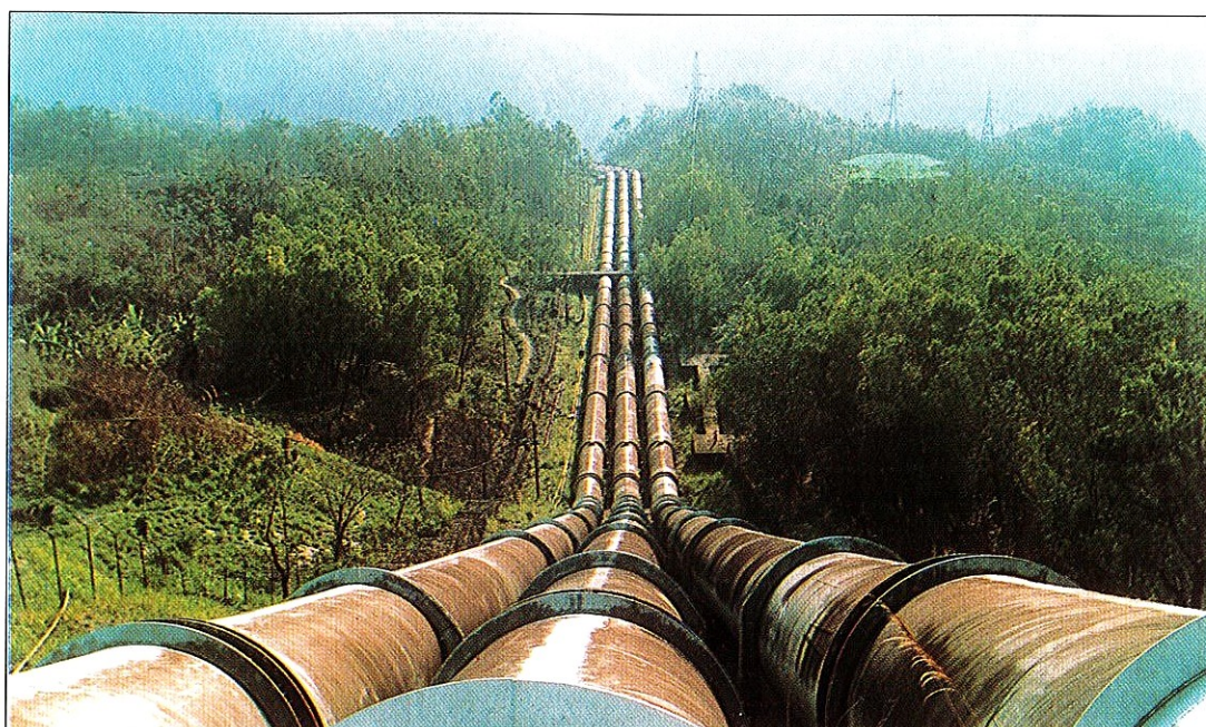
पेनस्टॉक - 105 मेगावाट, लोकतक पावर स्टेशन (मणिपुर) Penstocks - 105 MW Loktak Power Station (Manipur)
