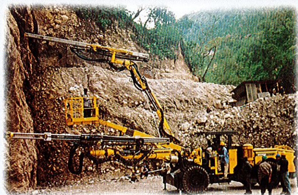
510 मेगावाट तीस्ता जल विद्युत परियोजना चरण-V, सिक्किम ( डाइवर्सन टनल के इनलेट पर ड्रिलिंग ऑपरेशन )
