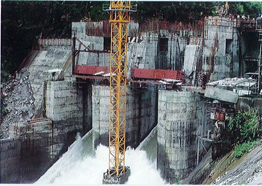
60 मेगावाट रंगित परियोजना (सिक्किम)-कंक्रीट बांध का निर्माण कार्य प्रगति पर
