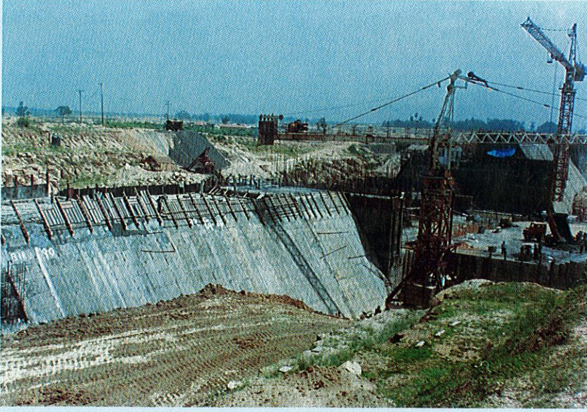
पश्चिम बंगाल में बकेश्वर थर्मल पावर प्लांट को पानी की आपूर्ति करने के लिए बकेश्वर नदी पर तैयार किया जा रहा कंक्रीट बांध
