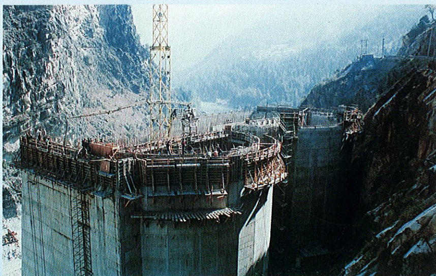
390 मेगावाट दुलहस्ती परियोजना (जम्मू व कश्मीर) - निर्माणाधीन इनटेक से पावर टनल का कार्य
