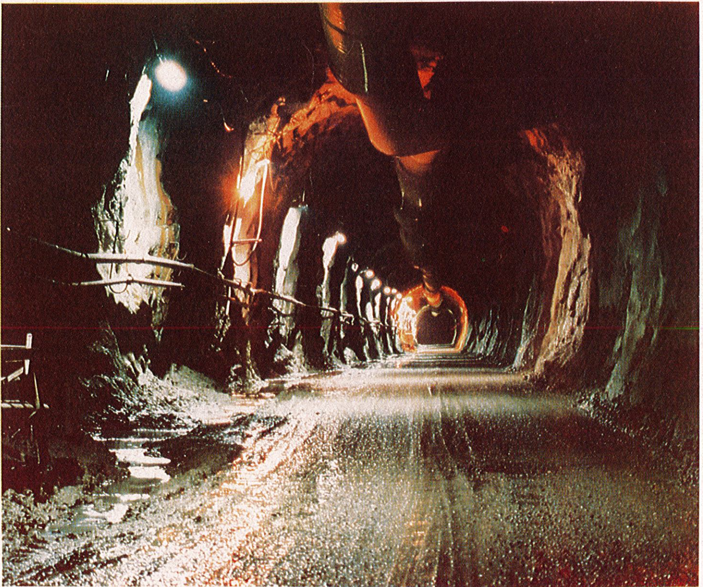
निर्माणाधीन टनल — उड़ी परियोजना।
