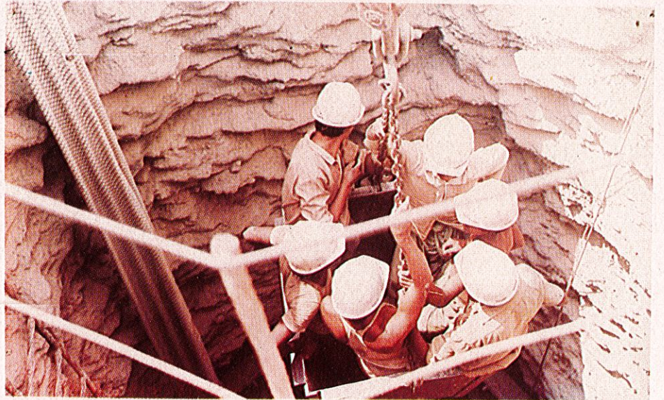
रंगित परियोजना के निर्माण — कार्य की प्रगति।
