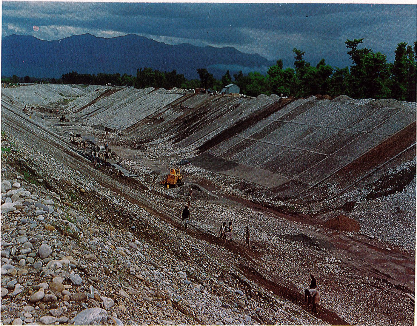
टनकपुर परियोजना — निर्माणाधीन पावर चैनल
