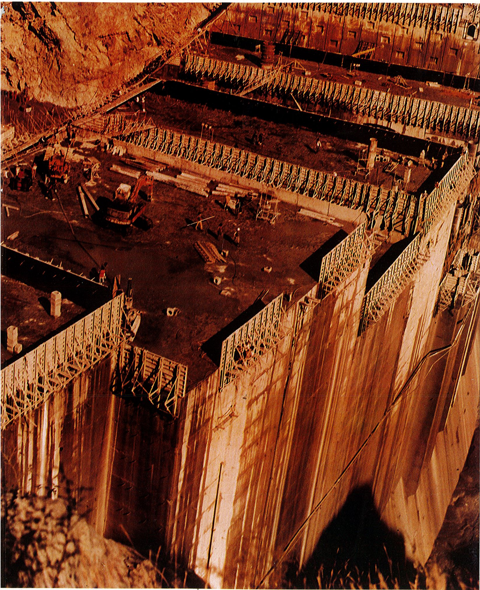
चमेरा परियोजना — निर्माणाधीन कंक्रीट बांध
