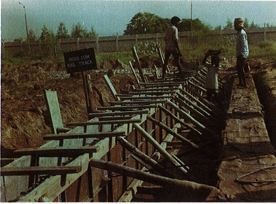
चमेरा ट्रांसमिशन सिस्टम — मोगा सब-स्टेशन निर्माणाधीन।
