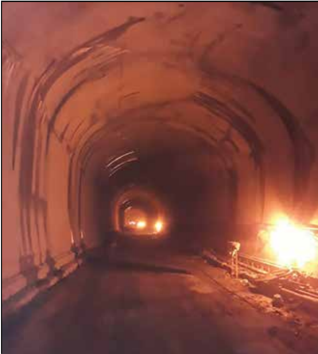
बांध स्थल तक पहुंच मार्ग टनल की लाइनिंग का कार्य प्रगति पर
