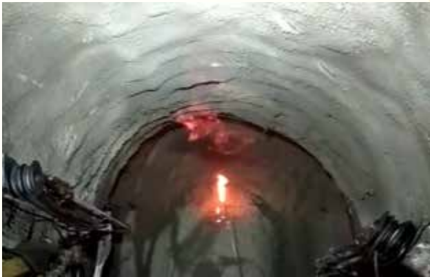
चित्र 2 मल्टी गैस डिटेक्टर द्वारा कम सघनता वाली सुरंग में मिली मीथेन गैस का उपचार
