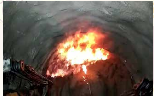
चित्र 2 मल्टी गैस डिटेक्टर द्वारा कम सघनता वाली सुरंग में मिली मीथेन गैस का उपचार
