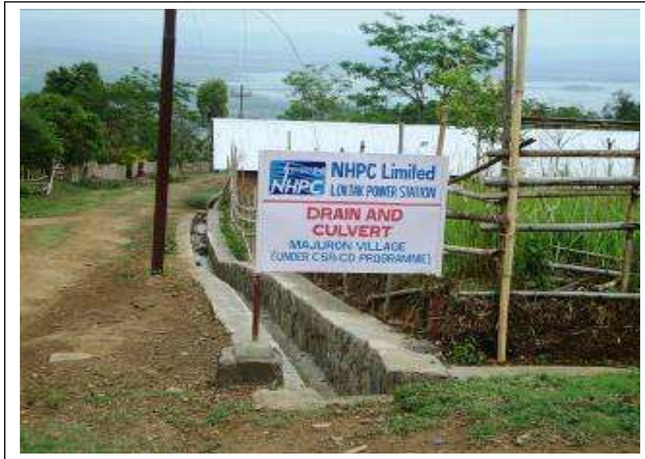
लोकतक विद्युत स्टेशन, मणिपुर में नाले का निर्माण
