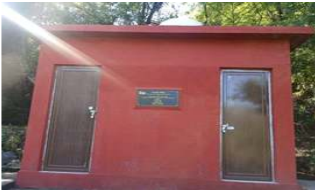
खड्डी में शौचालय का निर्माण
