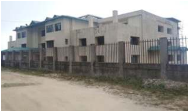
तकदाह, दार्जिलिंग, पश्चिम बंगाल में निर्माणाधीन इंजीनियरिंग कॉलेज
