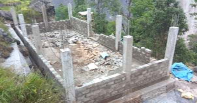
(खेला गांव के तोक चेतकला में अंडेडकर भवन का निर्माण कार्य)
