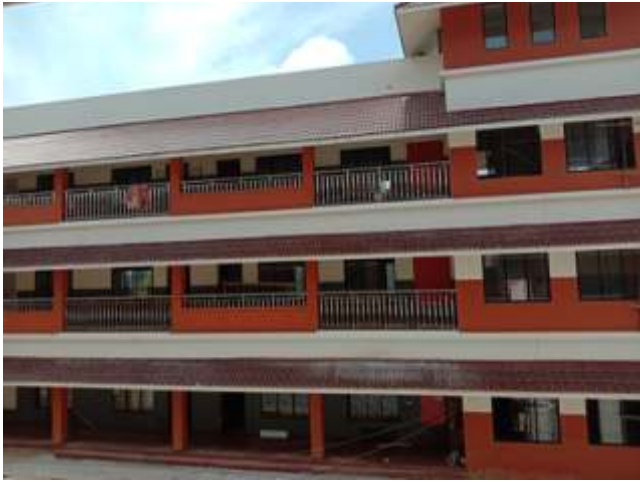
मुंडेरी सरकारी हायर सेकेंडरी स्कूल, कन्नूर, केरल में कक्षाओं का निर्माण
