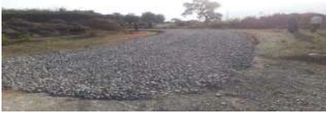
बिडड़ा गांव में निर्माणाधीन सड़क के ब्लैक टॉपिंग का कार्य
