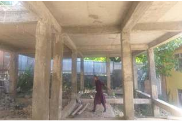
भूकंप से क्षतिग्रस्त स्कूल भवन की अवसंरचना का उन्नयन
