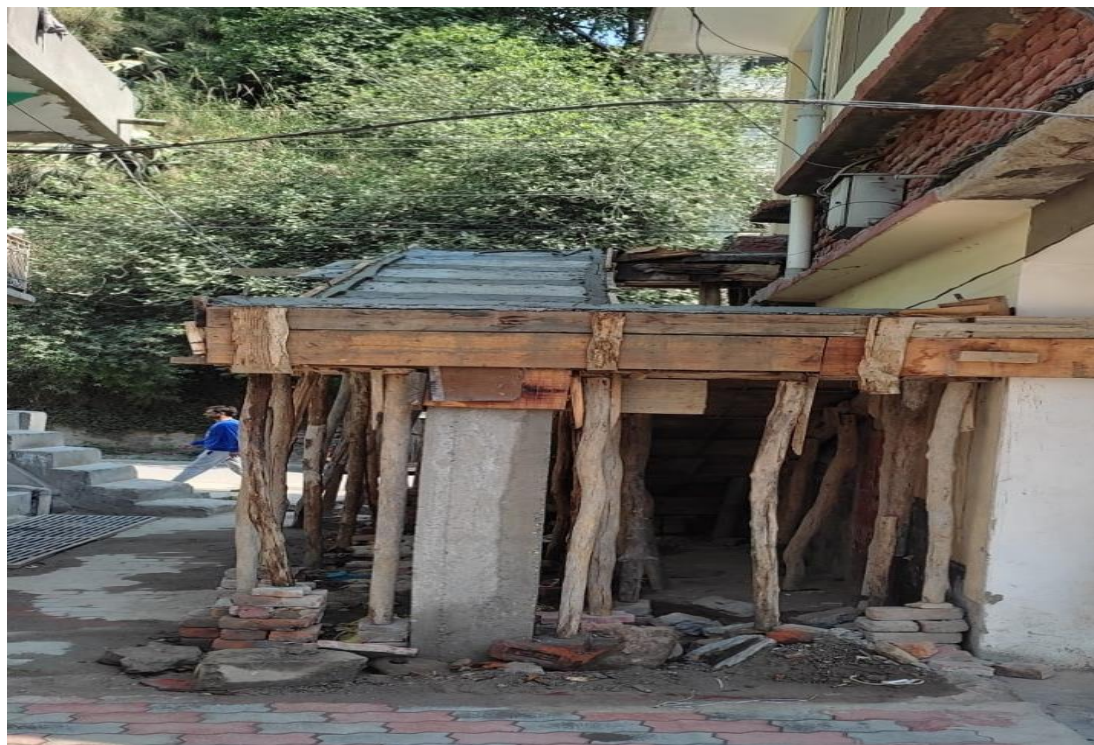
नव चेतना स्कूल, कुल्लू में रैम्प का निर्माण कार्य प्रगति पर
