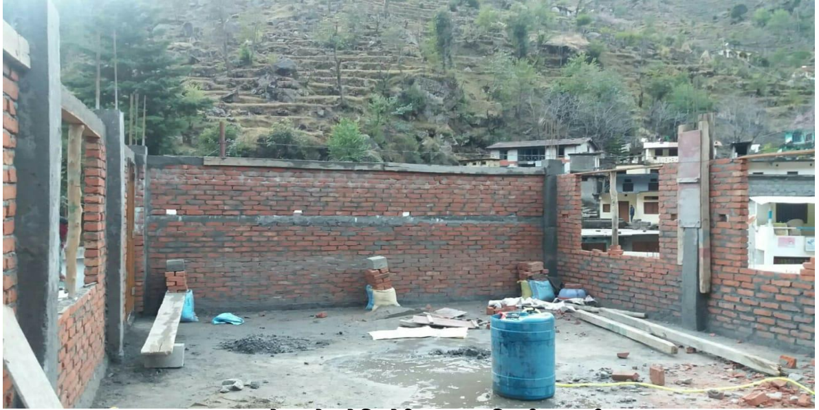
ग्राम खेला में ओडिटोरियम का निर्माण कार्य
