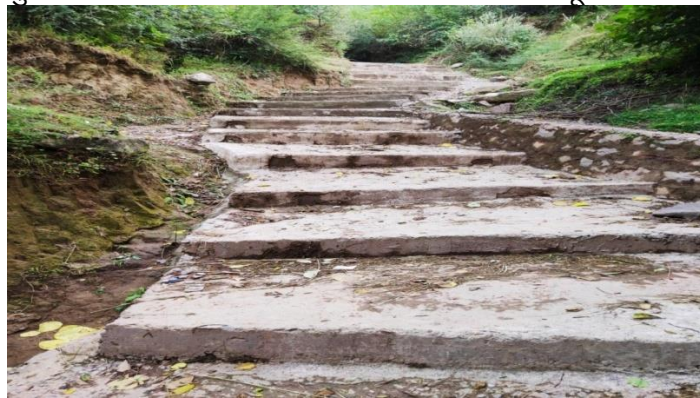
चित्र- शमशान घाट और शमशान घाट तक रास्ते का निर्माण
